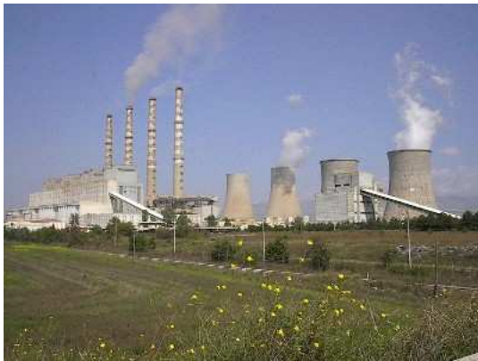
Θερμοηλεκτρική Μονάδα στη περιοχή Πτολεμαΐδας
