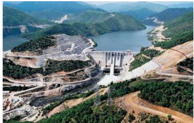
Πανοραμική άποψη του υδροηλεκτρικού σταθμού της Πλατανόβρυσης
