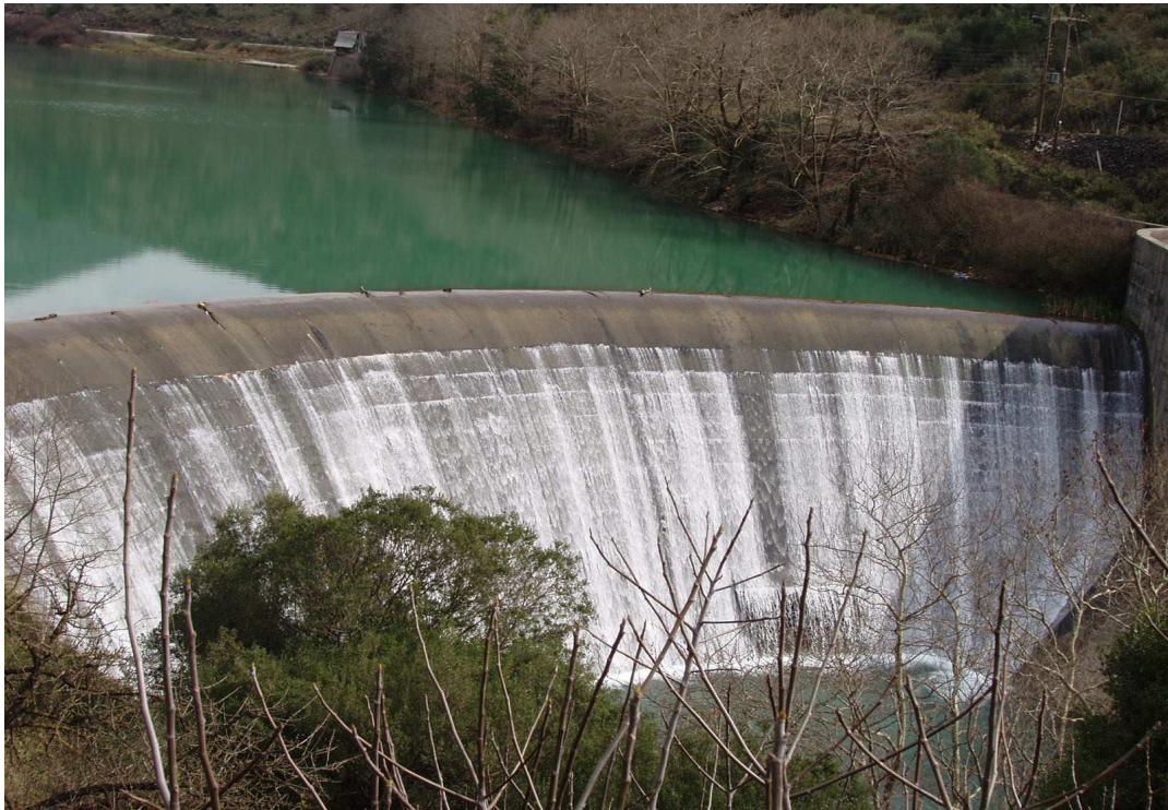
Φράγμα Λούρου (φωτ. Δ. Ζαραβέλα)
