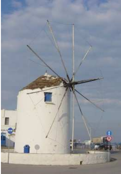
Μορφή ανεμόμυλου οριζόντιου άξονα που συνηθίζεται στις Κυκλάδες http://upload.wikimedia.org/wikipedia/commons/3/3a/CycladesWindmill06749.jpg
