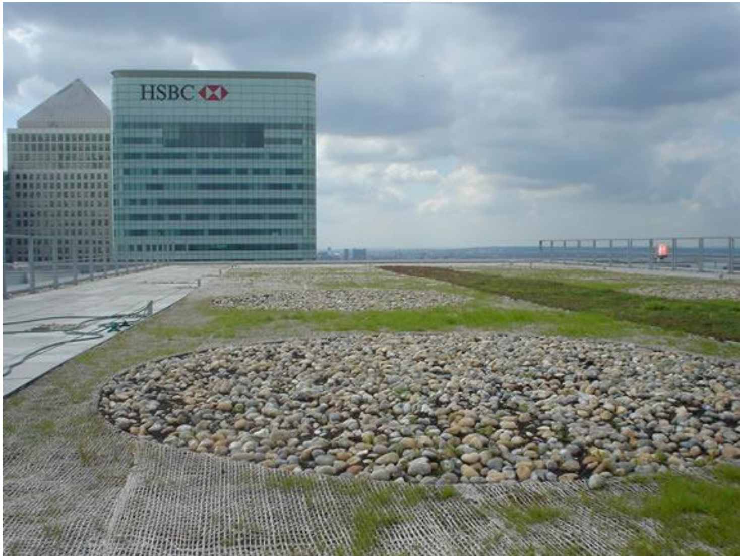
Εκτετατική πράσινη στέγη / σχεδιασμός για βιοποικιλότητα. Barclays Headquarters, Canary Wharf, Λονδίνο
