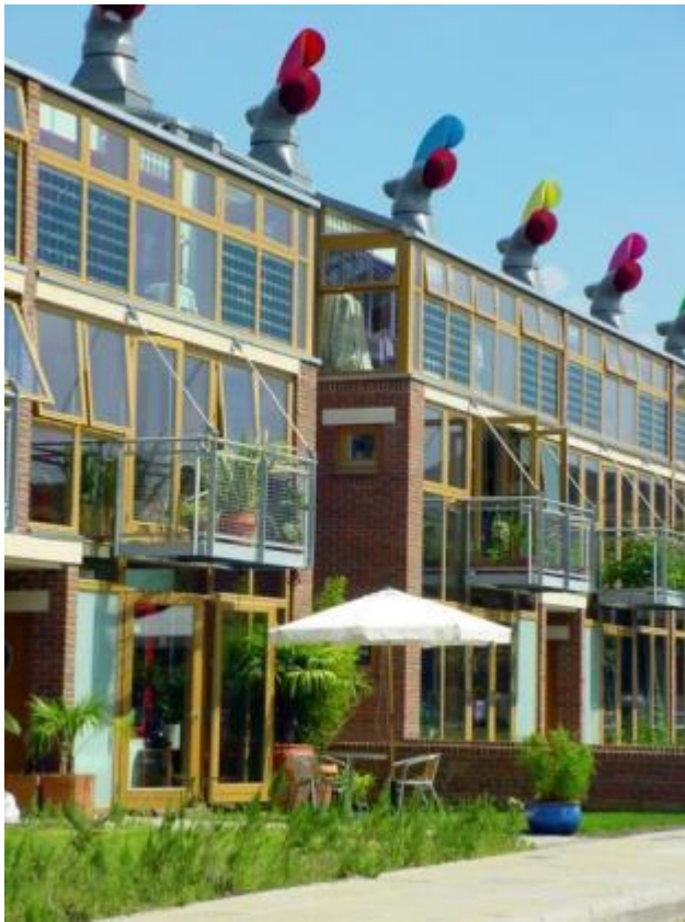
Νοτια όψη με ανοιγόμενα υαλοστάσια
