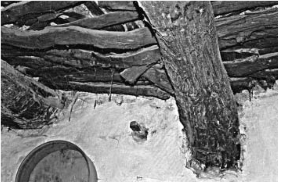
Πιν. 6β. Νοφαλιάς: λεπτομέρεια οροφής με μεσοδόκια και δοκάρια από το σπίτι του Φρουζή (εικ. 3/8).
