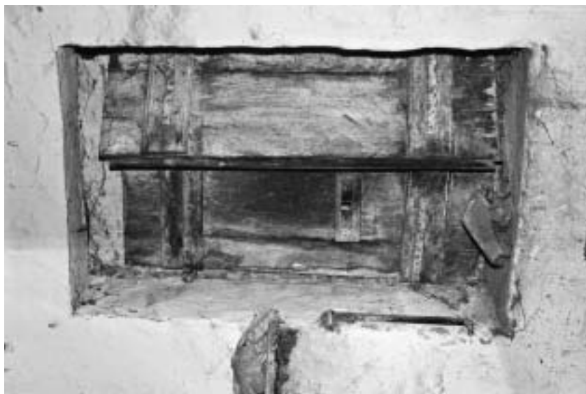
Πιν. 10β. Νοφαλιάς: παράθυρο με δίφυλλα σκούρα στο σπίτι του Αρακαδογιάννη (εικ. 3/27). Αριστερά διακρίνεται το σιδερένιο κοντομηρί.
