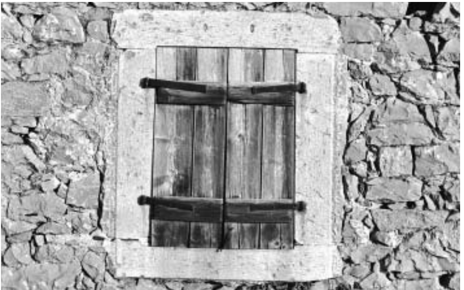
Πιν. 36β. Νοφαλιάς: σπίτι του Δεσποτογιώργη, παράθυρο με καρφωτά σκούρα από την πίσω όψη του οντά.
