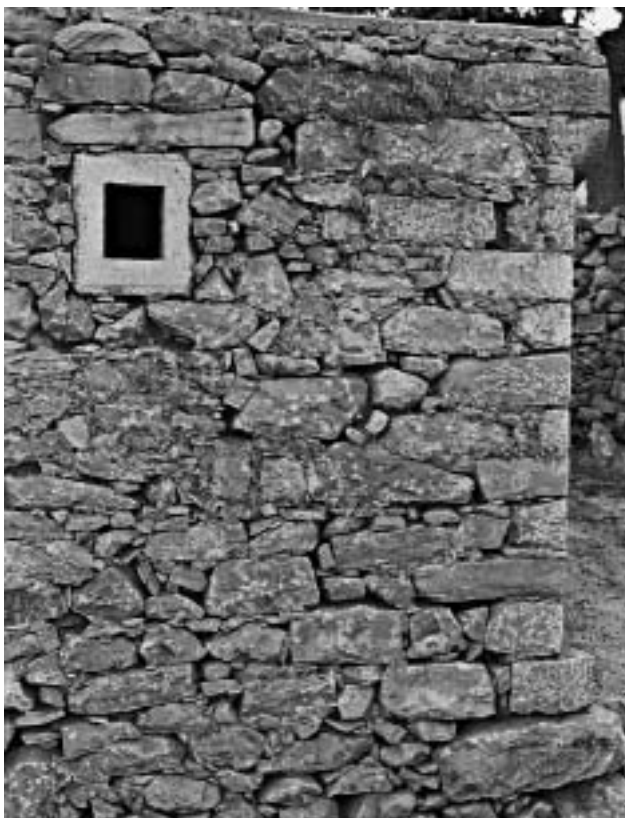
Πιν. 33β. Νοφαλιάς: σπίτι του Λυροσταυρούλη, λεπτομέρεια της βόρειας γωνίας με το λοξόμητο ρούκουνα και θυρίδα με ολόσωμο ανάγλυφο πλαίσιο.
