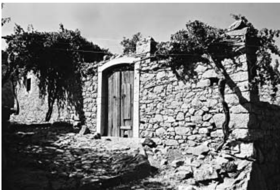
Πιν. 5α: Περονίδες: ψηλός αυλότοιχος από ξερολιθιά και τοξωτή αυλόθυρα με δίφυλλο κούφωμα στο σπίτι του Βοτυραντώνη.
