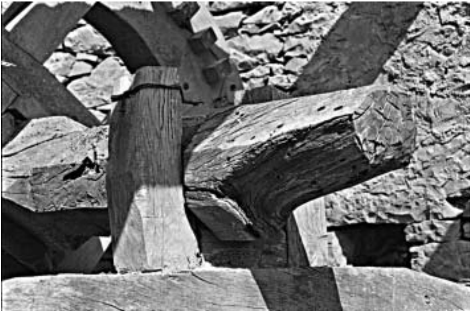
Πιν. 40α: Νοφαλιάς: λεπτομέρεια της πίσω στήριξης του αξονιού στον μύλο του πιν. 28.
