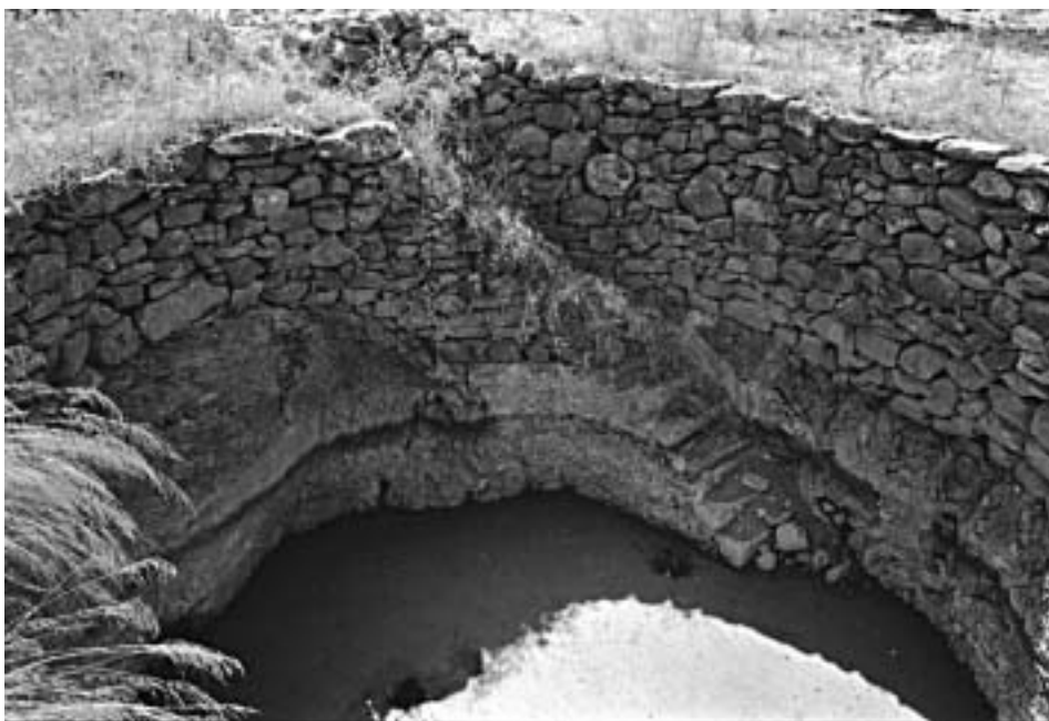
Πιν. 1β. Αμυγδαλιάς: εσωτερική κατασκευή της στέρνας του Καββάλο.
