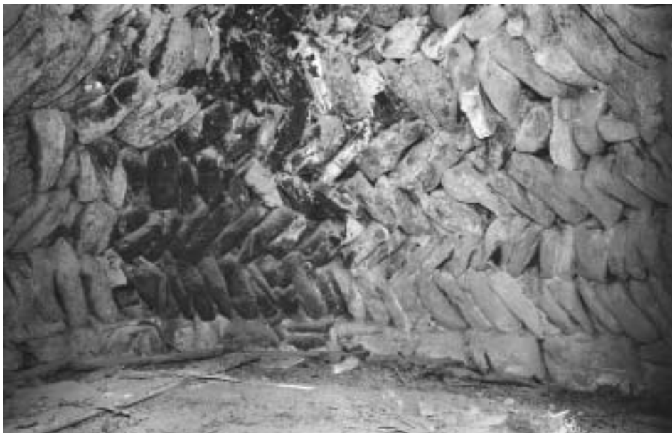
Πιν. 18β. Αμυγδαλιάς: λεπτομέρεια κατασκευής τού δόλου από το φούρνο του γερο-Σύσκου.
