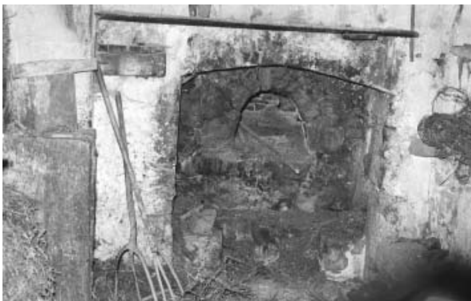
Πιν. 17β. Νοφαλιάς: συνδυασμός τζακιού με φούρνο στο σπίτι του Δεσποτογιώρ- γη. Αριστερά διακρίνονται δύο διχάλια.
