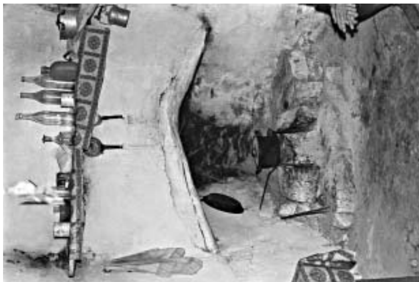
Πιν. 12α. Νοφαλιάς: γωνιακό τζάκι με καμφορικό στηριγμένο σε κορμό δένδρου, από το σπίτι του Φρουζή.
