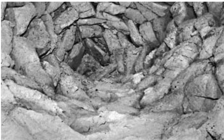
Πιν. 18α. Νοφαλιάς: λεπτομέρεια από το δόλο τού μεγάλου φούρνου στο φουρνόσπιτο του Τσολομανόλη, σήμερα κατεστραμμένου: εκφορική κατασκευή και κεντρικό αρδούνι.
