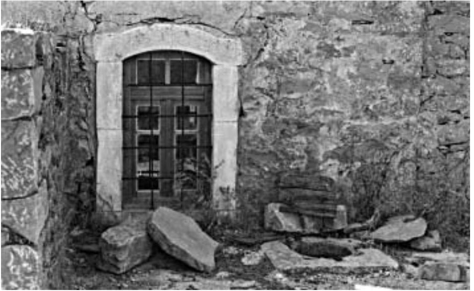
Πιν. 36α. Νοφαλιάς: σπίτι του Δεσποτογιώργη, παράθυρο με λίθινο πλαίσιο και δίφυλλο τζαμωτό κούφωμα από την πρόσοψη της κουζίνας του οντά. Μπροστά, το στόμιο της εκεί δολωτής στέρνας.
