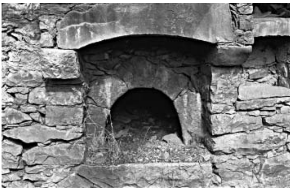
Πιν. 17α. Νοφαλιάς: ο μεγάλος φούρνος από το φουρνόσπιτο στο σπίτι του Τσο- λομανόλη, με καμαρικό επάνω σε κάνους και ανηφορά.
